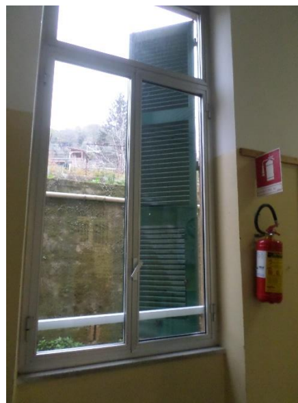
Figura 4.1 - Particolare dell'involucro murario al piano terra
