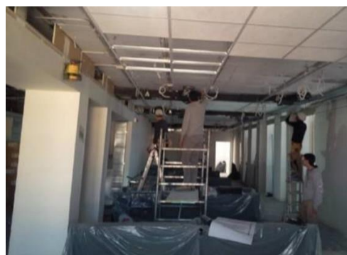
Figura 8.6- Particolare installazione controsoffitti
